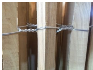
Valla empalizada Alambres galvanizados \varnothing 1,8 mm
