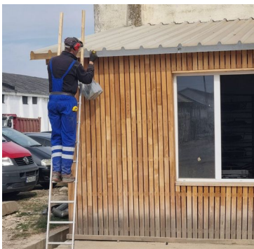
Fassadenholz keilgezinkt, gerade, 23 mm
