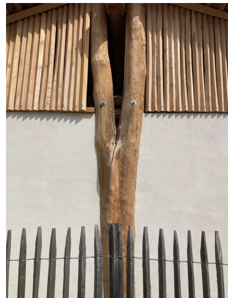
Arbre poncé en « Y » en soutènement d'une pergola
