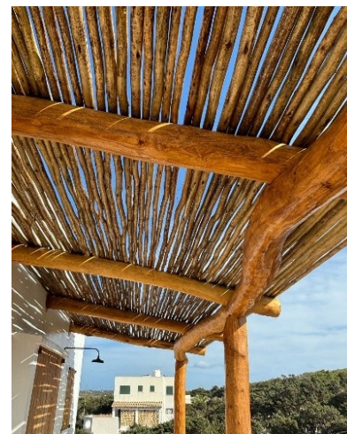
Toiture de pergolas, perches en eucalyptus
