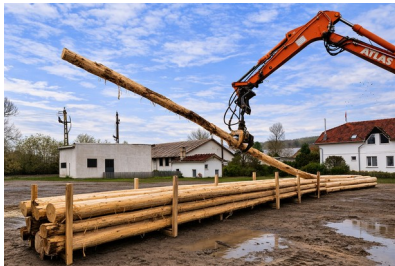
Geschälte Masten 12 m lang
