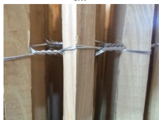
Schapenhek Gegalvaniseerde draden \varnothing 1,8 mm
