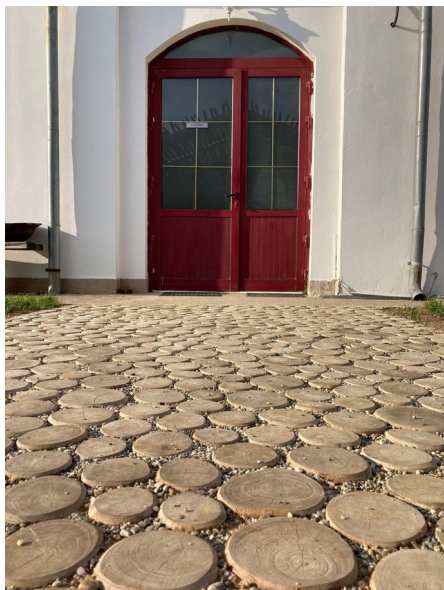
Pavés en robinier, avec aubier , diamètres variés
