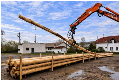
Postes pelados de 12 m de largo
