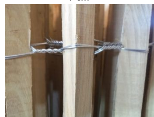
Staketenzaun Verzinkte Drähte \varnothing 1,8 mm
