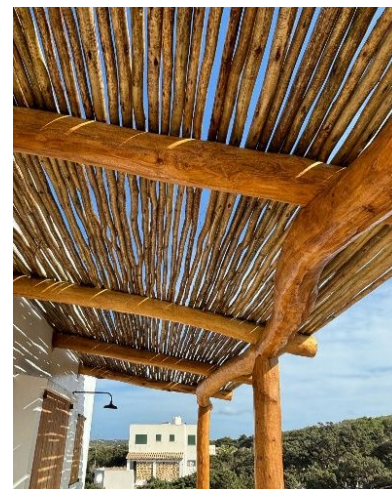
Cubierta de pérgolas, varas de eucalipto
