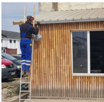
Placare îmbinată cap la cap, profil drept, gros. 23 mm
