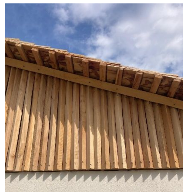
Dreieckige Fassadenlatten Umfang 15-20 cm
