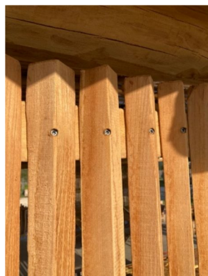
Dreieckige Fassadenlatten Umfang 15-20 cm
