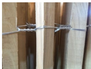
Gard în role Sârme galvanizate Ø 1,8 mm
