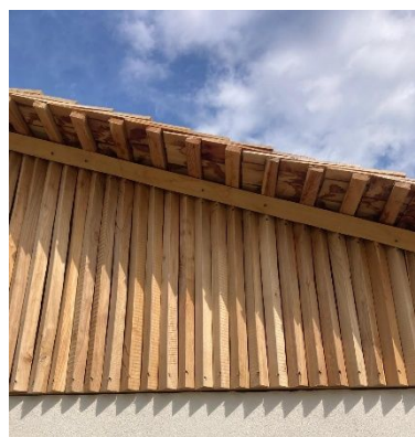
Listones triangulares de fachada Perímetro 15-20 cm
