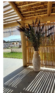
Listones triangulares de fachada Perímetro 15-20 cm
