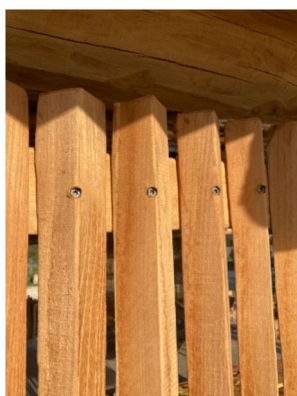
Listones triangulares de fachada Perímetro 15-20 cm
